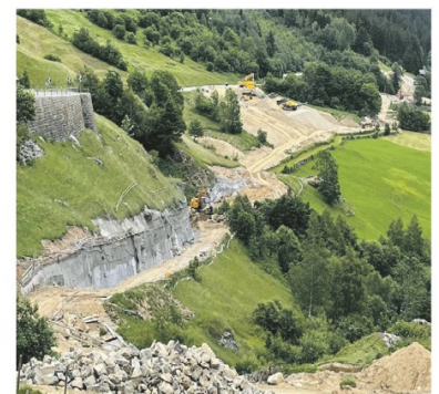
Bau der Druckleitung im Meiental.
